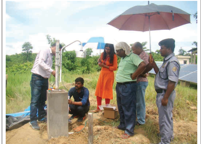
आकृति 32 MPGO, दक्षिण अंडमान में GNSS रिसीवर प्लेटफॉर्म का निर्माण।
